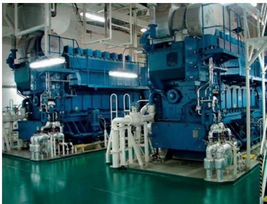
Pour l'usine de La Hague, en cas de perte d'alimentation en électricité (pouvant entraîner la perte de la vapeur et/ou de l'air comprimé), l'établissement doit assurer sa mise en sûreté [scénario pris en compte dans l'analyse de sûreté], le refroidissement des matières nucléaires étant assuré par des groupes diesel de secours.
